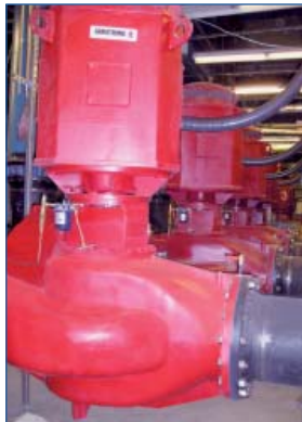
Centro de enfriamiento del distrito de Enwave, Toronto, Canadá.
